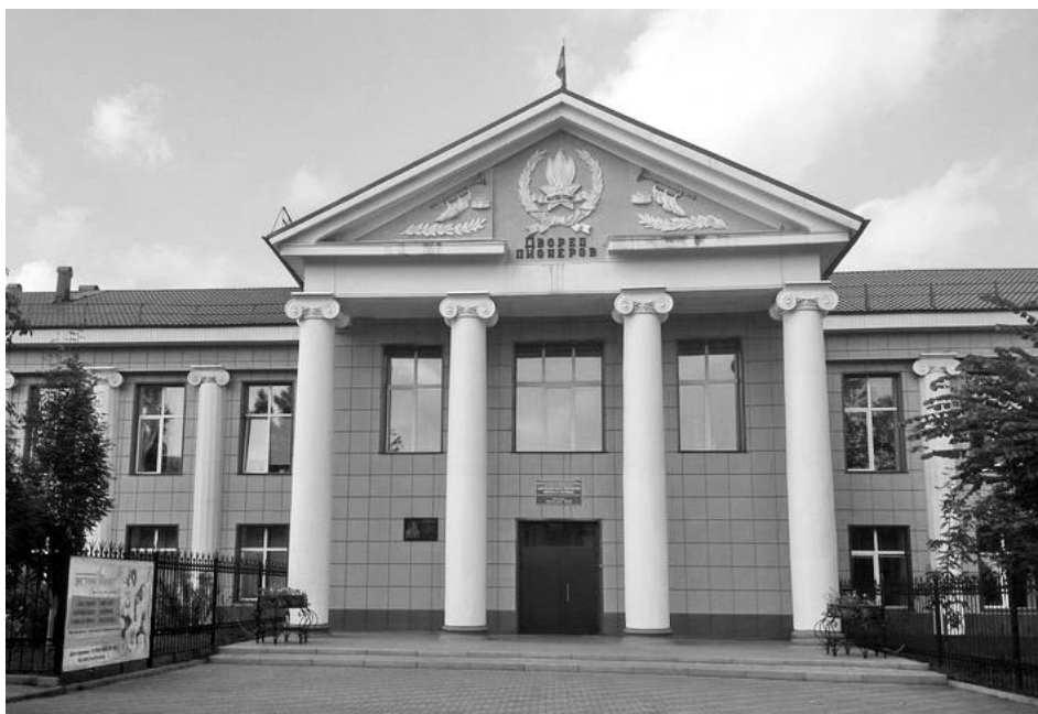
Дом пионеров в г. Прокопьевске
